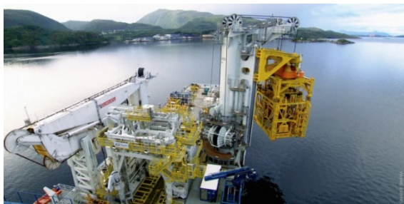
Installation der Kompressoreinheiten auf dem Åsgard-Feld – © Statoil ASA
