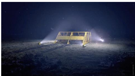
Åsgard-Unterwasserstation auf dem Meeresgrund – © Statoil ASA
