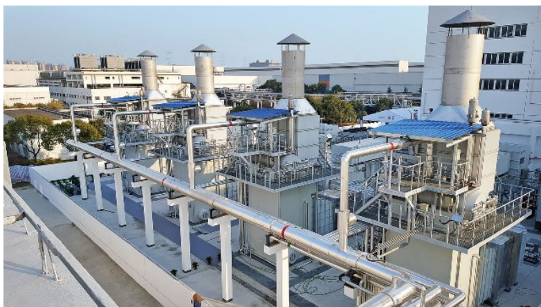
(MAN_MGT_VW_Shanghai.jpg) 四台 MGT 透平机为上海市郊的大众汽车工场供电和供暖。
