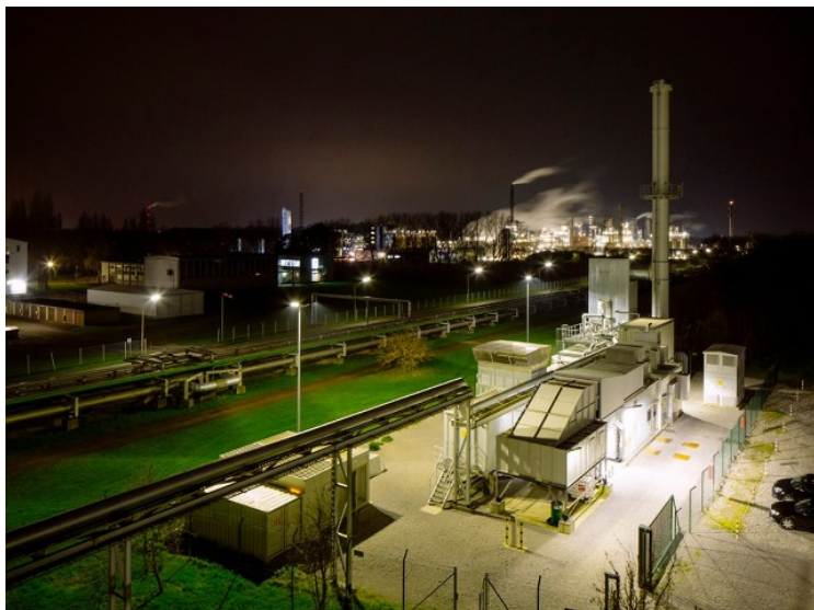
(MAN_MGT_1. jpg) 例如德国莱茵贝格的这家发电厂，MGT 透平机以高效的热电联产模式供电和供暖。
